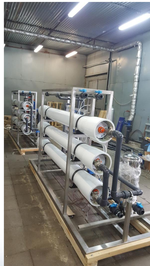
Équipement permettant d'obtenir de l'eau de haute pureté de 16 Mom \* cm pour la cogénération de PGU à Saki (osmose inverse 2 unités x 7 m<sup>3</sup> / h, électrodéionisation 2 unités x 7 m<sup>3</sup> / h
