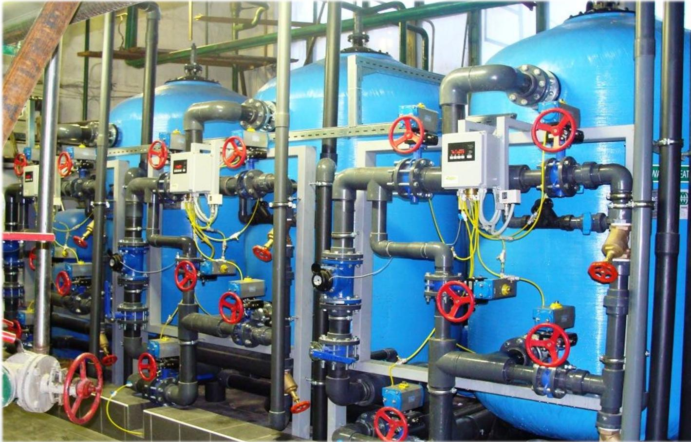
Station d'élimination des sels de dureté par échange d'ions pour une chaufferie à vapeur de Wimm Bill Dann OJSC, 120 m<sup>3</sup> / h
